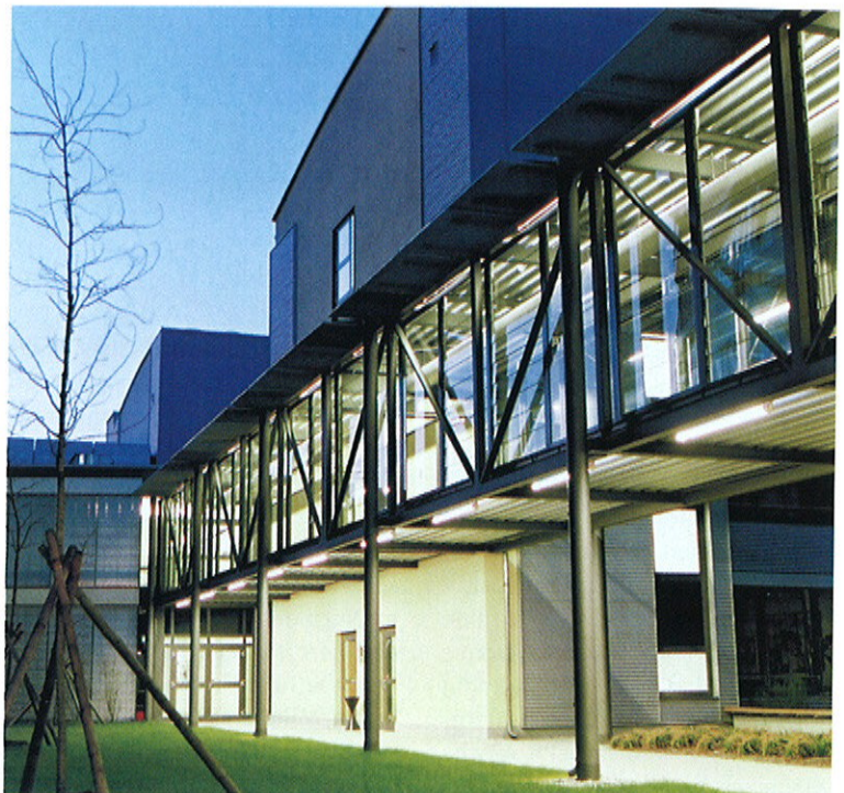
Im Rahmen eines modernen Bauprojektes ist die Gebäudeautomation heute von grösster Bedeutung.
