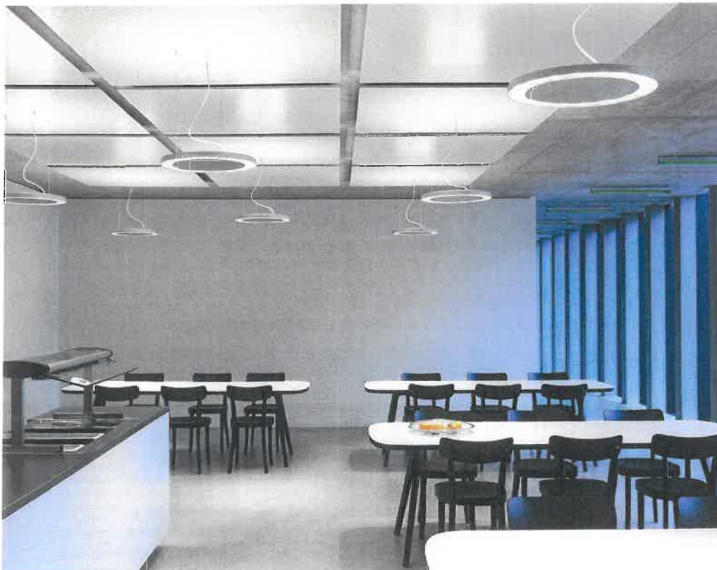
Früher wurden die Luftmengen für Büro- oder andere Aufenthaltsräume noch für Raucherräume ausgelegt. Heute gilt hier meist ein generelles Rauchverbot. Durch eine Anpassung der Luftwechsel können die Luftmengen so reduziert werden, dass kleinere Motoren der neusten Energieklasse eingesetzt werden können. (Foto: Minergie AG-1189, Safenwil).
